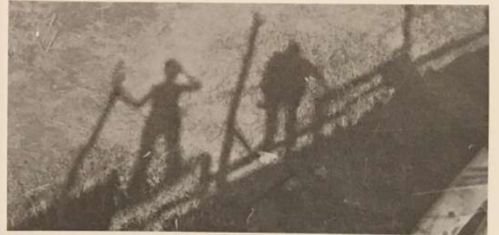
Starting the first houses. Die ersten Häuser werden errichtet.
